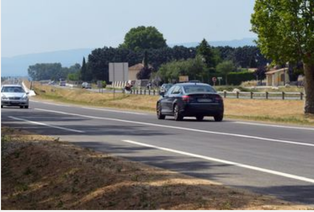
La déviation entre Cadenet et Villelaure (RD 973)
