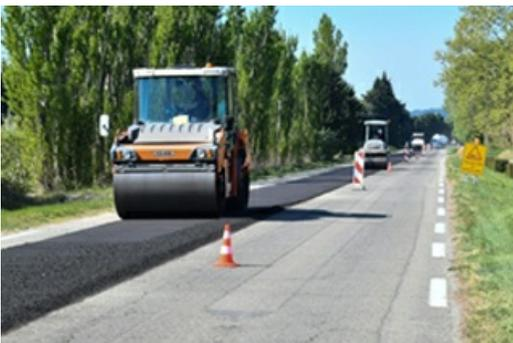
La technique de réparation utilisée consiste en un retraitement mixte des matériaux de chaussée existants (recyclage des enrobés). Concrètement, il s'agit de récupérer les matériaux existants de la chaussée, sur une épaisseur variant de 6 à 8 cm suivant les sections, et de les mélanger à froid, sur place, avec un mélange de ciment et d'émulsion, pour recréer un corps de chaussée en bon état. Une nouvelle couche de roulement est ensuite mise en place.
