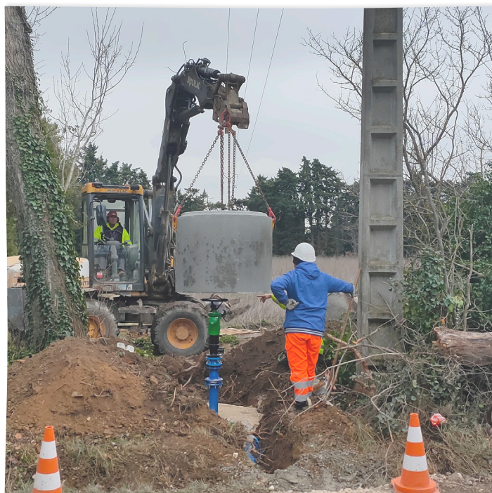
Pose de borne lors de modernisation sur le secteur de l'Isle. © Canal de l'Isle
