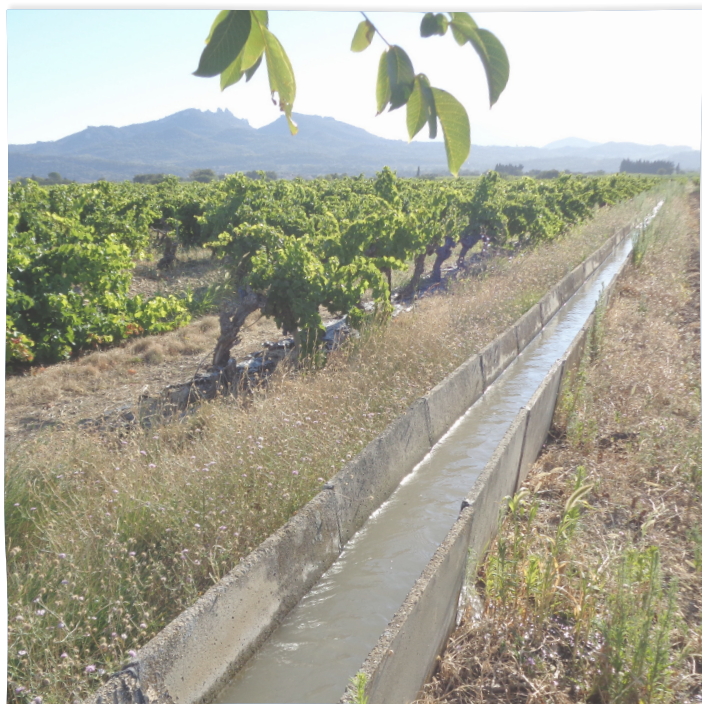
Filiolo gravitaire sur le canal de Carpentras. © Canal de Carpentras
