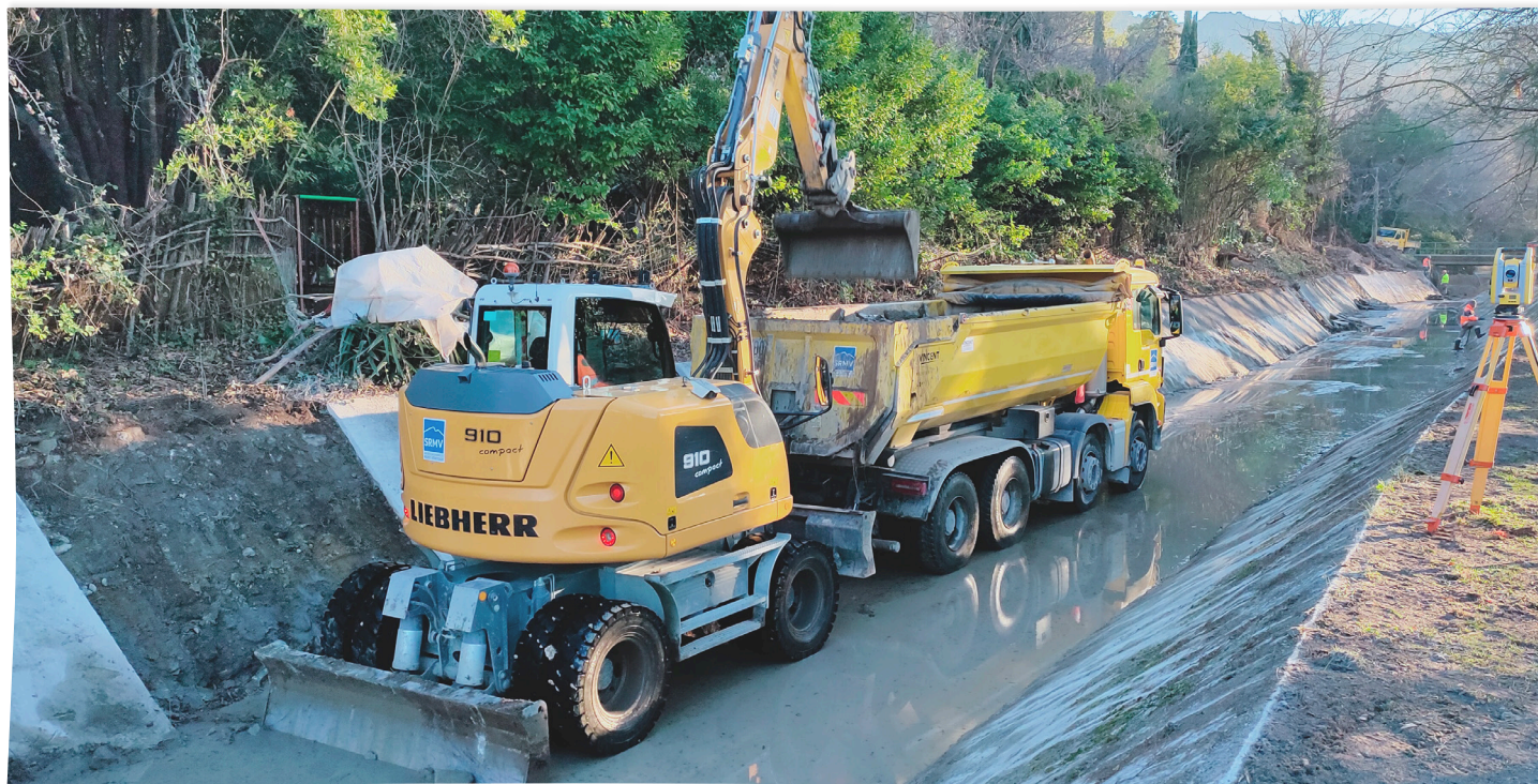
Travaux de préparation au cuvelage menés sur le canal de l'Union Luberon Sorgue Ventoux © Canal de l'Isle
