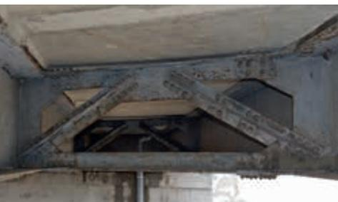
Le Pont de Fontcouverte souffre de dégradations structurelles importantes. La dernière inspection a confirmé la dégradation avancée de la structure de l'ouvrage : corrosion avancée de l'ensemble des poutres métalliques et dégradation du béton des piliers de l'ouvrage. C'est pourquoi il est impératif de réparer et sécuriser l'ouvrage afin d'assurer sa pérennité.
