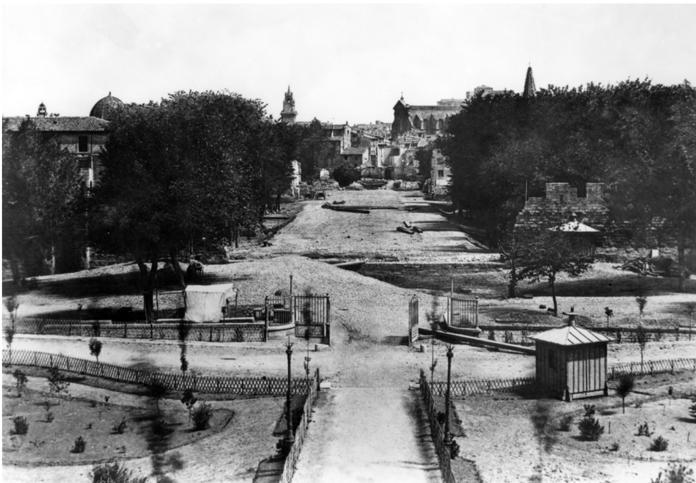
Avignon : percement de la rue de la République vu de la gare. (cliché de duplication provenant de la Caisse Nationale des Monuments Historiques et des Sites). Photo : Edouard Baldus.
