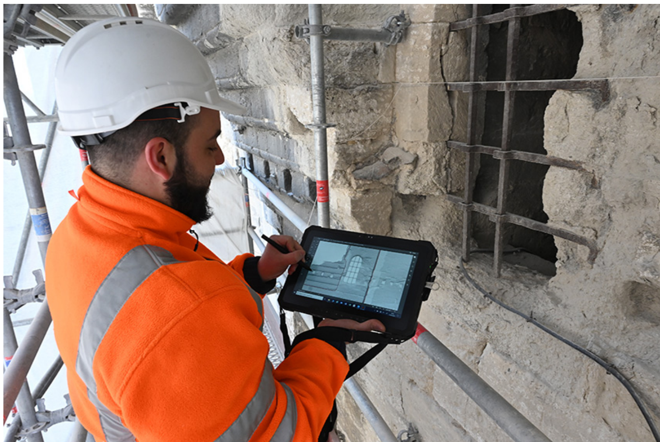
Les archéologues utilisent une tablette numérique pour réaliser un relevé « pierre à pierre ».
