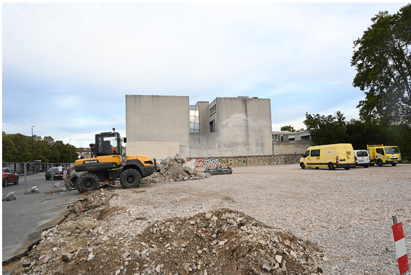
Les travaux permettent de purger les fondations de l'ancien hangar Souvet et d'habitations adjacentes.
