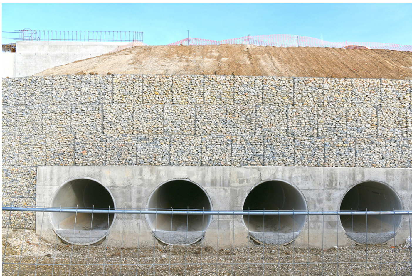
Des ouvrages hydrauliques sont créés pour le bon écoulement de l'eau lors de fortes crues.
