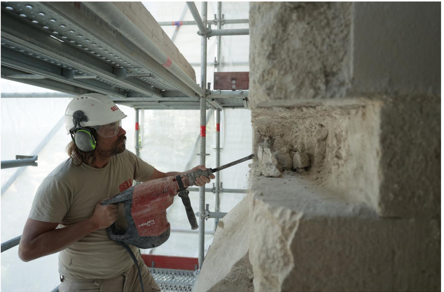
*Si certains travaux peuvent être soulagés par l'emploi d'outils mécanisés, comme ici pour la dépose de la bûche de pierre, les techniques utilisées sur le chantier restent traditionnelles.*
