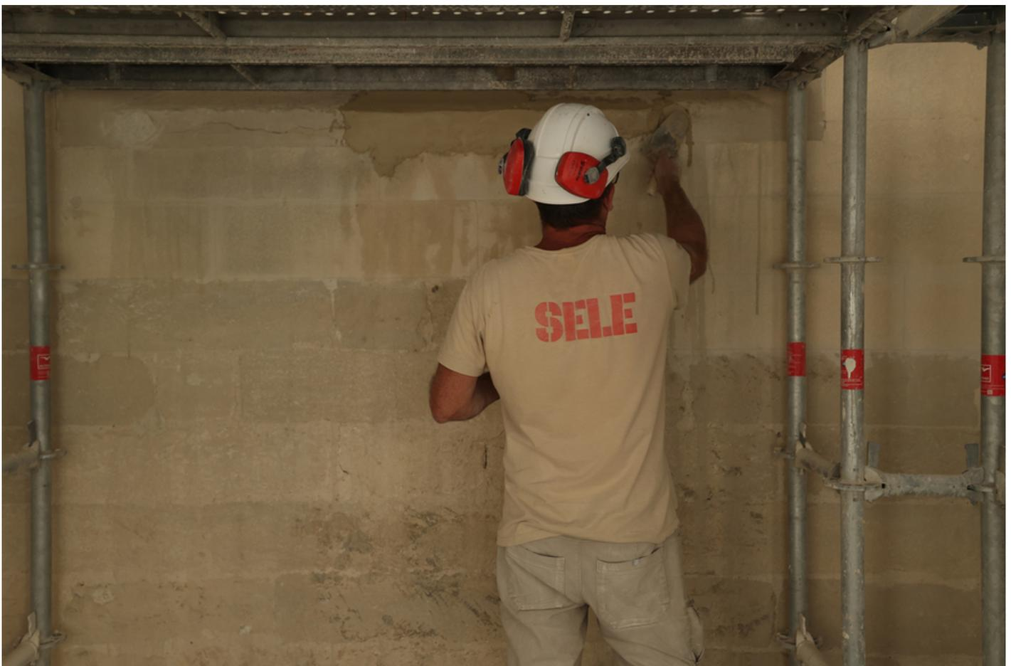
*Le ragréage consiste à reconstituer de la pierre cassée, lorsqu'un remplacement de la pierre n'est pas nécessaire, avec de la chaux et du sable, comme on le faisait à l'époque.*
