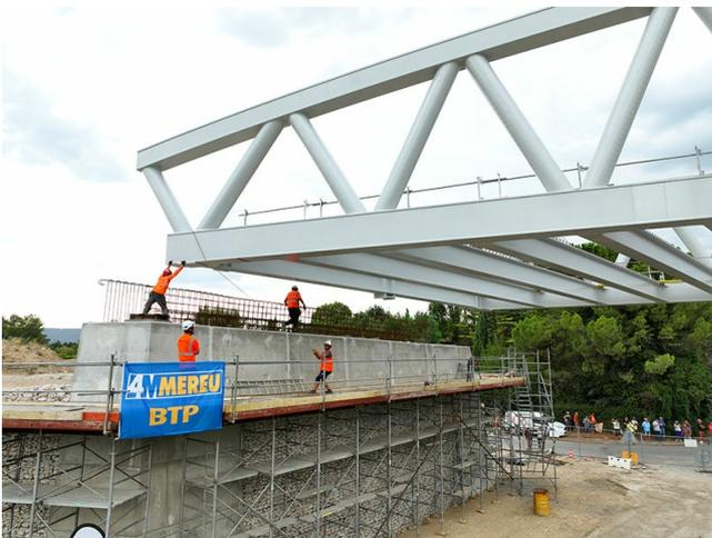
Ce chantier d'envergure a commencé en février dernier. Il prendra fin au début de l'année prochaine. Il s'agit d'installer un ouvrage mixte (acier/béton) comprenant une charpente métallique de 50 mètres de long et pesant 370 tonnes. Une opération d'envergure effectuée grâce à une grue d'une capacité de 650 tonnes afin de poser cette structure métallique.
