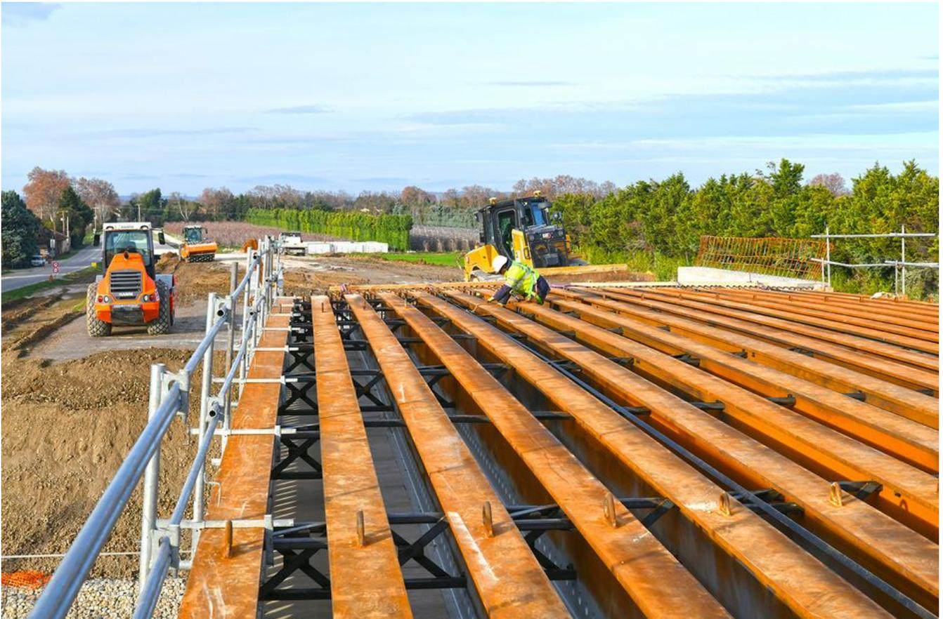
D'autres travaux vont être menés dans les prochaines semaines pour finaliser ce pont-route : ferrailage et bétonnage du tablier, mise en place des équipements, étanchéité et mise en œuvre de la chaussée. Il restera alors à procéder à une dernière étape : la suppression du PN 15, la réalisation de la nouvelle voie de circulation sur 1 600 mètres ainsi que l'élargissement de la RD 900, sur une section de 600 mètres, côté nord.
