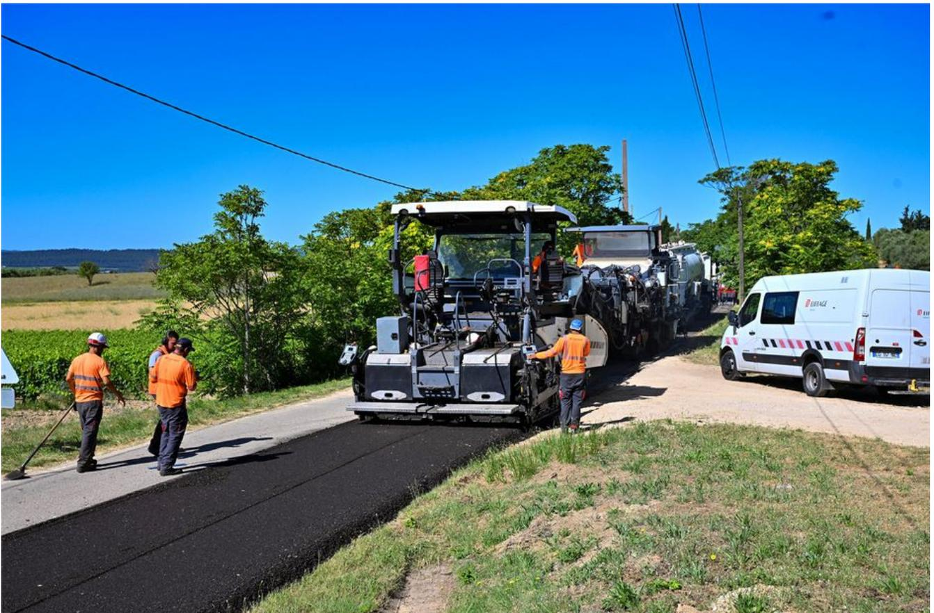
*La nouvelle route, plus écologique, sera composée de 100 % de granulats recyclés de l'ancienne chaussée et d'un liant végétal.*
