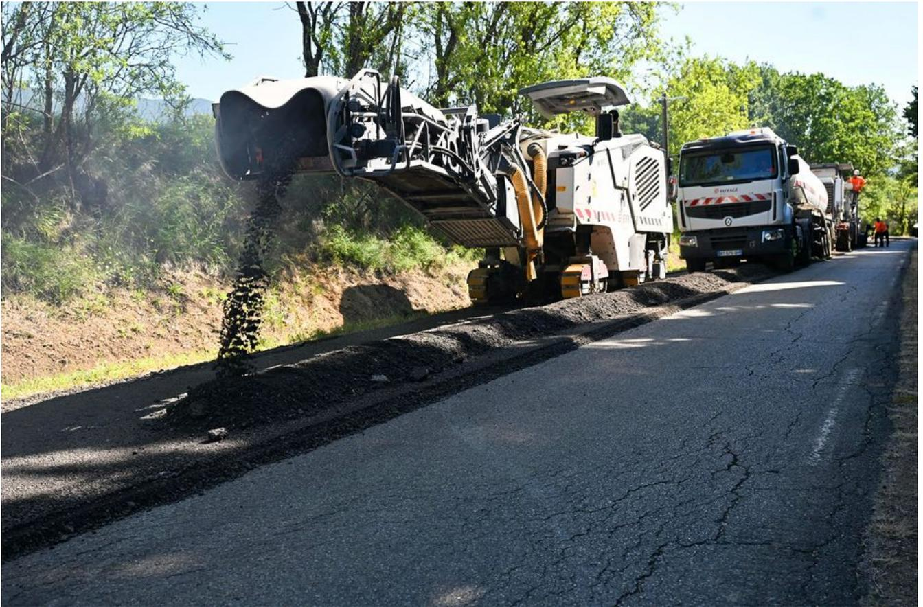
*Ce procédé nécessite un atelier de retraitement mobile, composé de plusieurs engins.*
