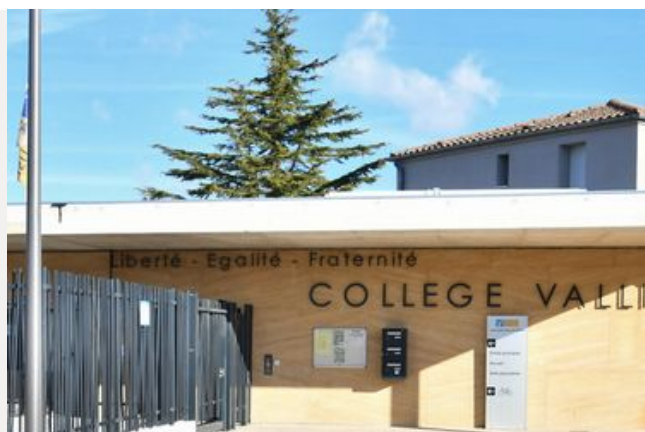
Restructuration du collège Vallis Aeria à Valréas
