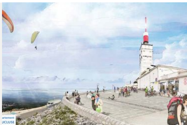
Réhabilitation du sommet du Mont Ventoux : Les travaux se poursuivent !
