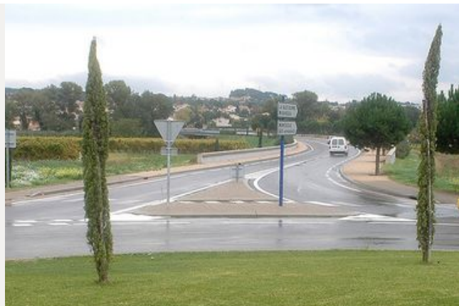
La liaison routière RD 120 - RD 956 à La Tour d'Aigues
