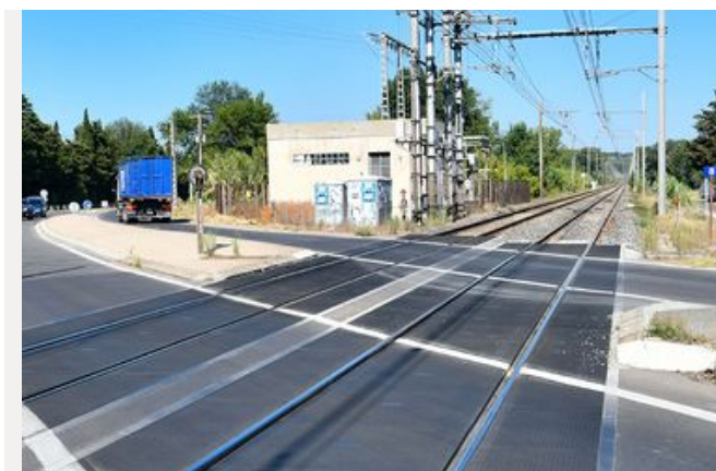
Aménagements de sécurité aux abords du passage à niveau n°8 (PN 8)
