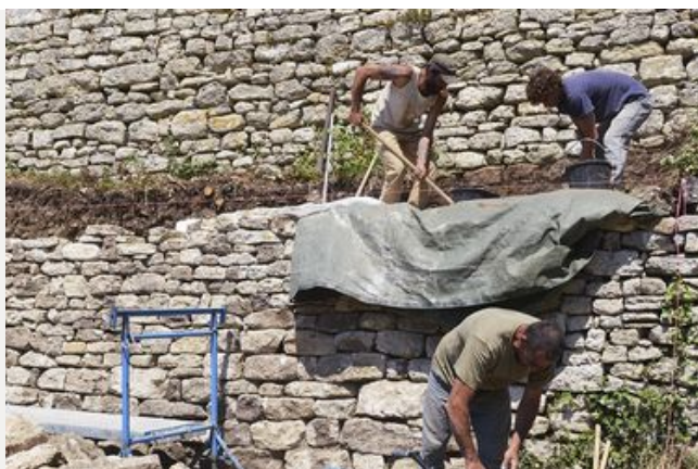
La préservation du patrimoine « pierres sèches »
