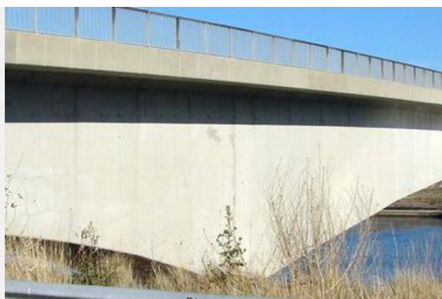
Pont du Tricastin à Bollène 2016
